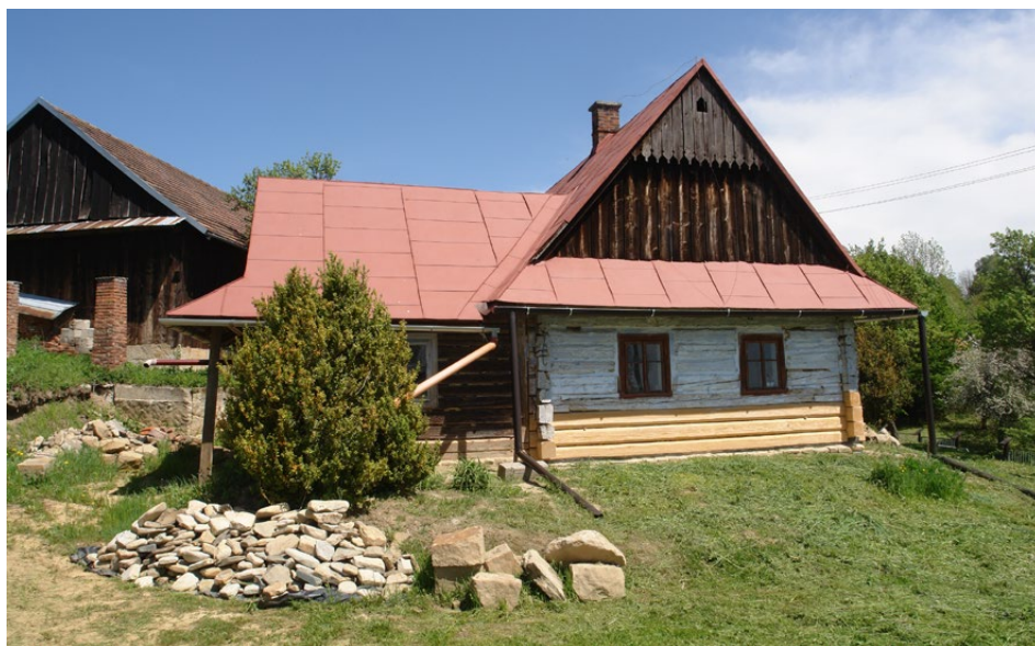
Il. 1. Widok ogólny zagrody rodzinnej Stanisława Pigoń od południowego zachodu, fot. T. Łopatkiewicz, maj 2020
