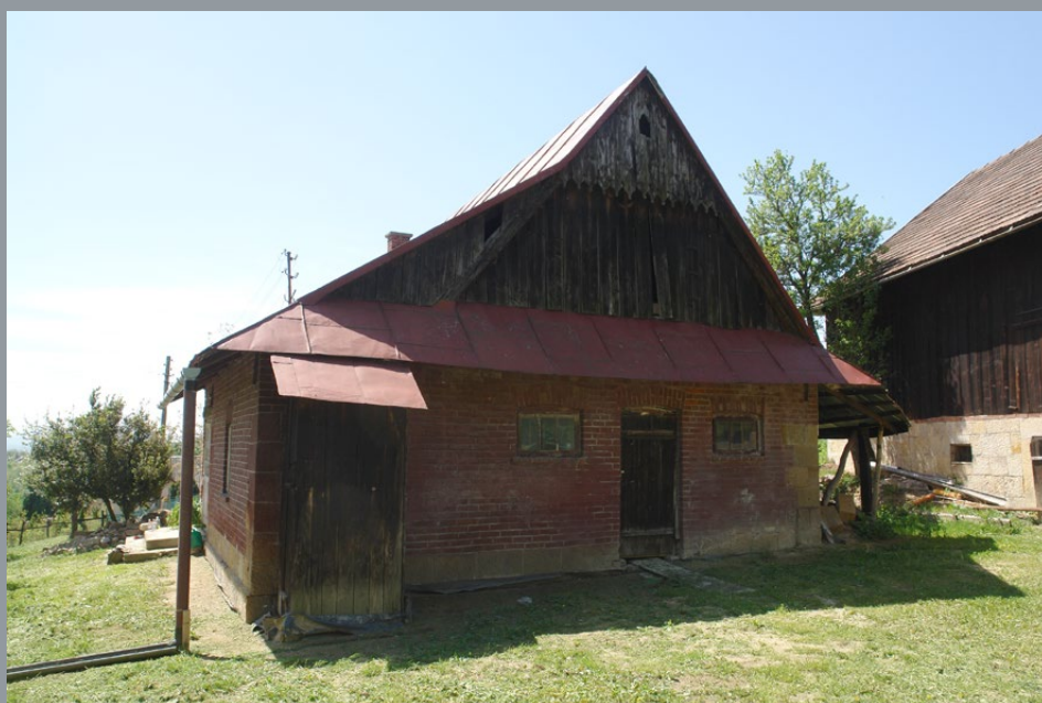
Il. 22. Szczytowa elewacja Pigońiówki w części gospodarczej domu. Widoczne drzwi oraz okna obory oraz nowa podmurówka i kamieniarskie narożniki ścian z piaskowca, fot. T. Łopatkiewicz, maj 2020
