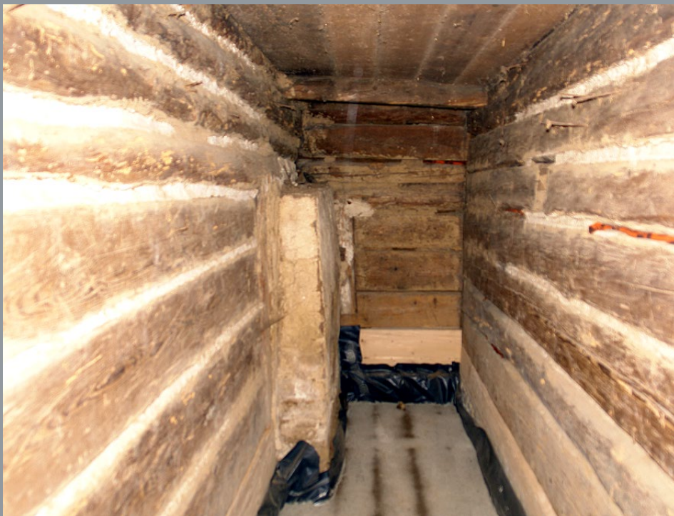
Il. 16. Wnętrze alkierza z nagrzewnicą po lewej stronie i niewielkim światlikiem w ścianie prawej, fot. T. Łopatkiewicz, maj 2020
