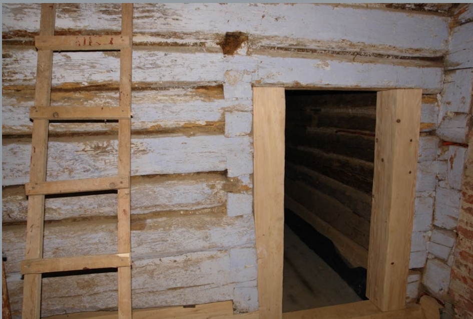
Il. 17. Odrzwia prowadzące do alkierza oraz węglowanie belek ścian na rybi ogon – przy lewym węgarze i obłap – przy prawym, fot. T. Łopatkiewicz, maj 2020
