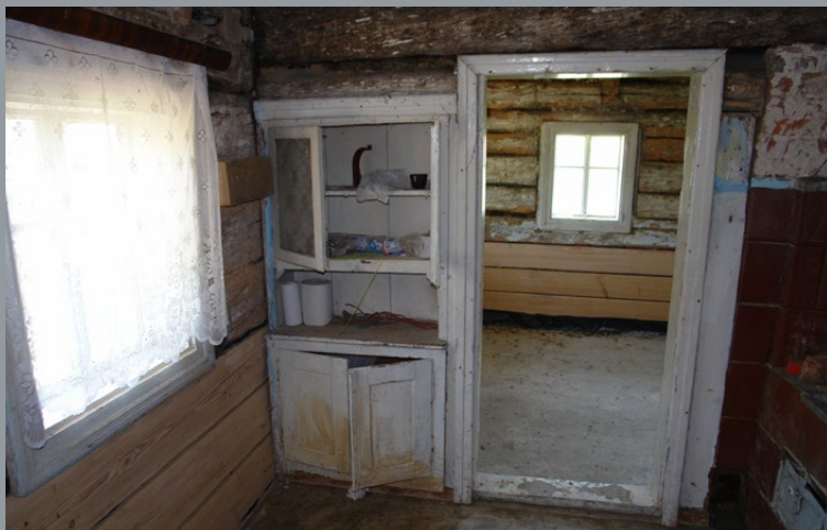
Il. 14. Drzwi prowadzące z izby do warsztatu połączone z szafką kredensową, fot. T. Łopatkiewicz, maj 2020
