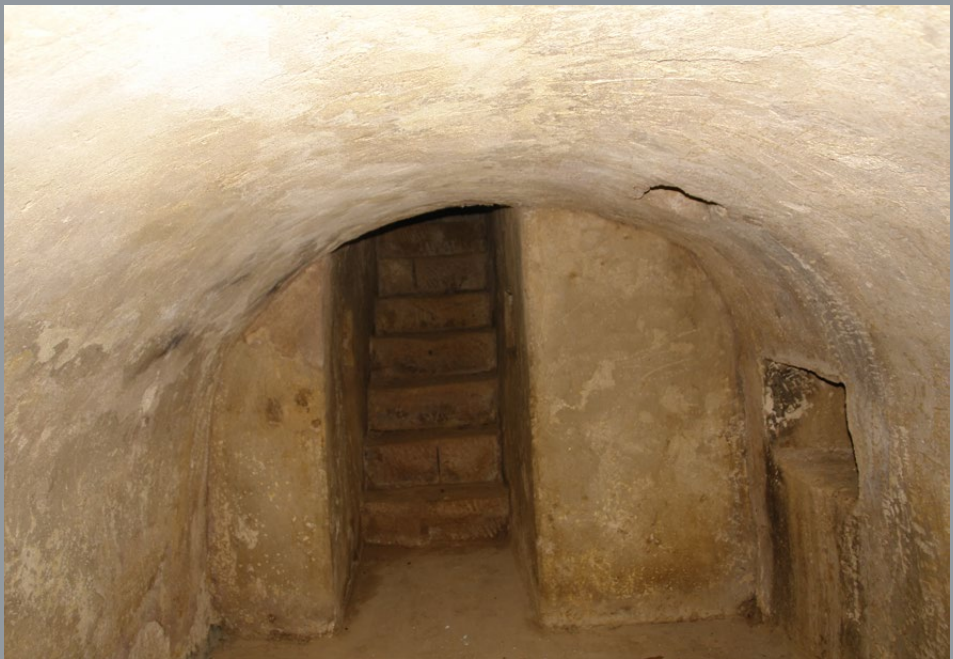
Il. 19. Piwnica i prowadzące do niej schody kamienne. W sklepieniu, po prawej, widoczny jeden ze zsyków, poniżej głęboka wnęka, fot. T. Łopatkiewicz, maj 2020
