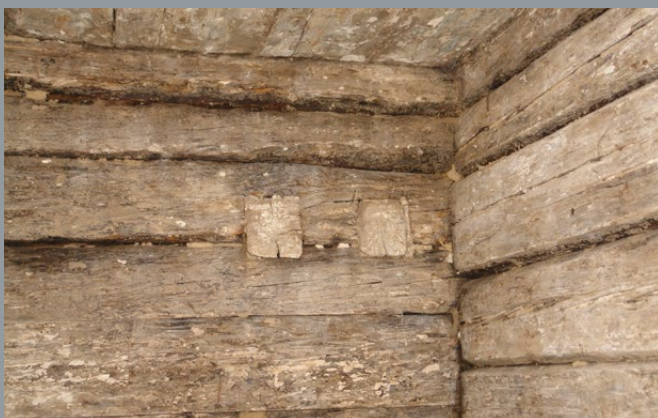
Il. 11. Relikwii dawnych poleni zachowane w zrębowych ścianach izby, fot. T. Łopatkiewicz, maj 2020
