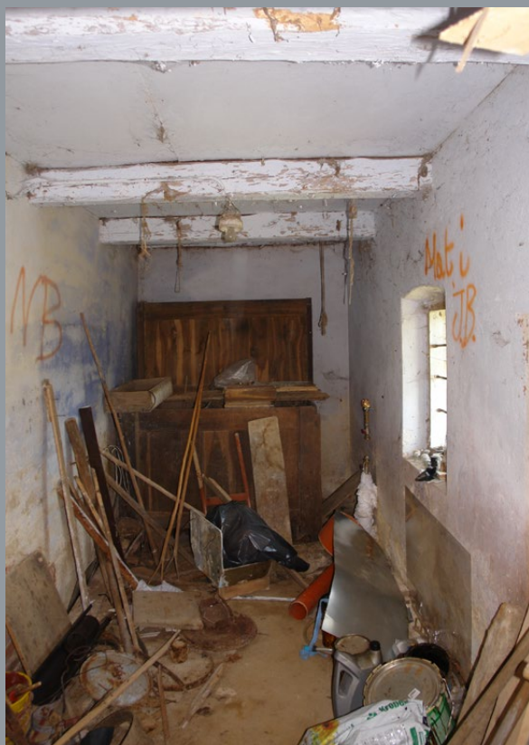
Il. 23. Wnętrze komory, fot. T. Łopatkiewicz, maj 2020
