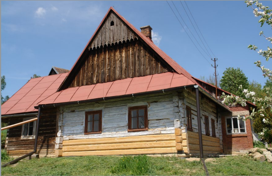
Il. 6. Widok ściany szczytowej dwuspadowego dachu chałupy, z przyczółkiem, ozdobnym szalunkiem i doświetleniem, fot. T. Łopatkiewicz, maj 2020
