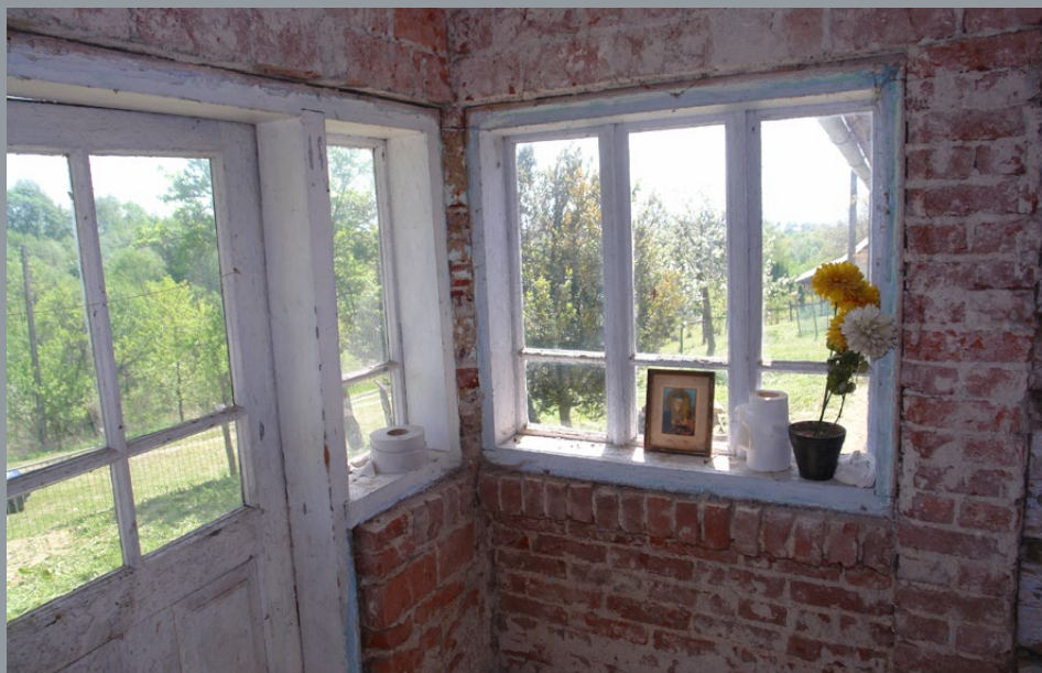
Il. 24. Widok z ganku (w trakcie remontu został ze ścian skuty stary tynk), fot. T. Łopatkiewicz, maj 2020
