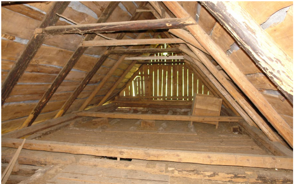
Il. 31. Widok na północno-wschodnią część poddasza z nowymi i starymi (ciemnymi od dymu) krokiewiami oraz jętkami, fot. T. Łopatkiewicz, maj 2020
