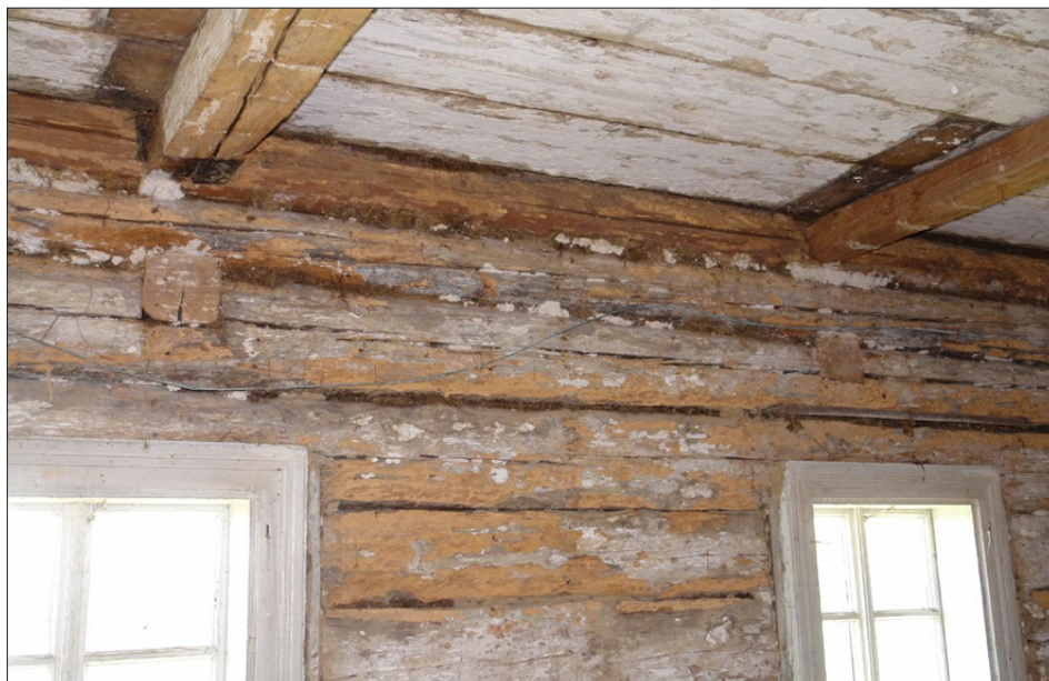
Il. 15. Ślady po dawnych belkach stropowych w warsztacie i ich nowy, wyższy układ, fot. T. Łopatkiewicz, maj 2020
