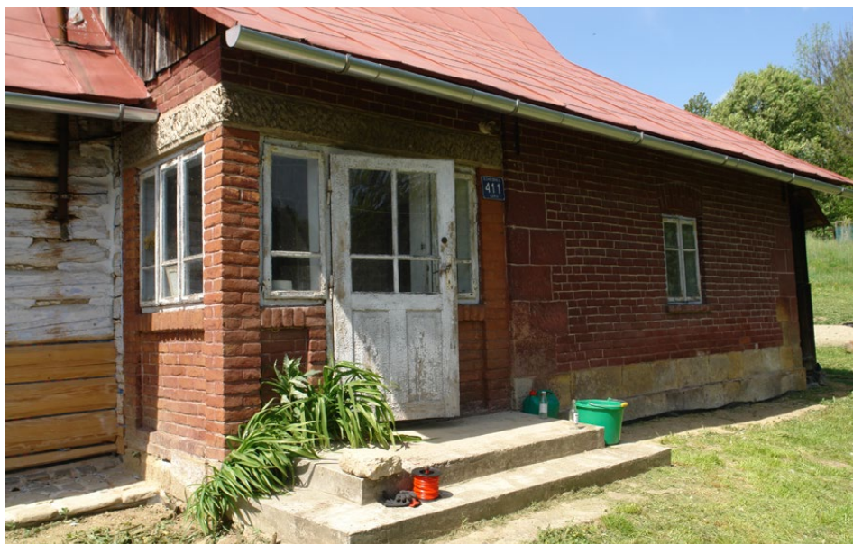
Il. 5. Ganek oraz frontowa ściana wymurowanej z cegły części gospodarczej domu, fot. T. Łopatkiewicz, maj 2020
