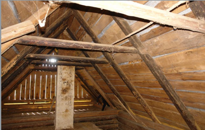
Il. 28. Południowo-wschodnia część poddasza Pigińcówki, ze starymi krokiewiami z czasów półkurności chałupy, fot. T. Łopatkiewicz, maj 2020
