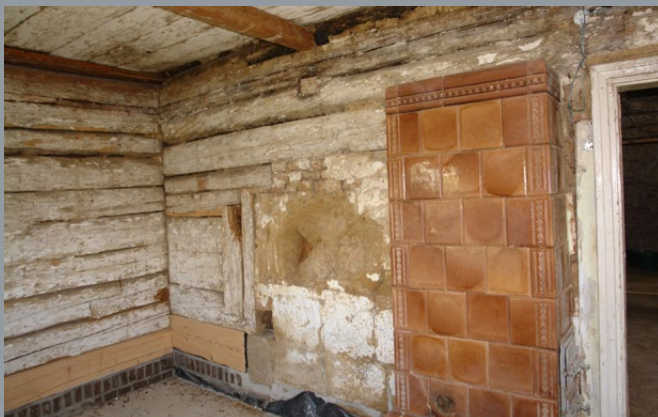
Il. 10. Wewnętrzna ściana warsztatu ze współczesnym piecem kaflowym oraz relikwiami wcześniejszych rozwiązań ciesielskich i zduńskich, fot. T. Łopatkiewicz, maj 2020
