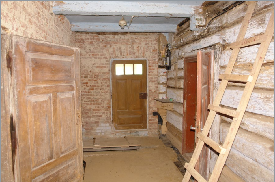
Il. 18. Widok sieni – część od frontu. Po lewej – drzwi do obory, w posadzce – właz do piwnicy, na wprost – drzwi na ganek, po prawej – wejście do izby (ze śladami okoplenia zrębu ponad nadprożem) i drabina prowadząca na strych, fot. T. Łopatkiewicz, maj 2020
