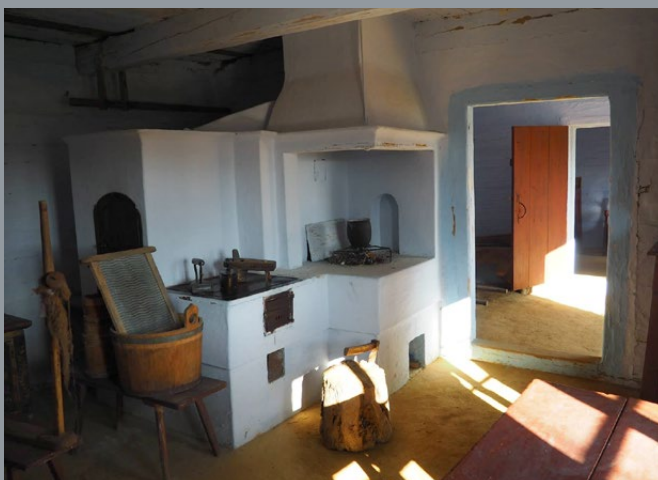
Il. 9. Przykład pieca z kapką, zachowany w domu rodzinnym Wincentego Witosa w Wierzosławicach, wzniesionym na przełomie lat 30. i 40. XIX wieku, https://lekkim-okiem-m.blogspot.com/2015/12/wierzoslawice.html , odczyt z 10 lipca 2020
