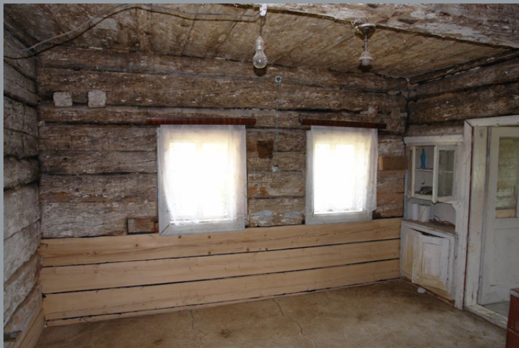
Il. 13. Okna w izbie, ponad którymi – po bokach – relikty belek poleni , fot. T. Łopatkiewicz, maj 2020
