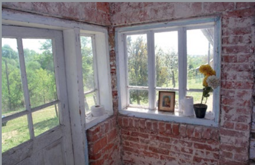
Il. 24. Widok z ganku (w trakcie remontu został ze ścian skuty stary tynk), fot. T. Łopatkiewicz, maj 2020
