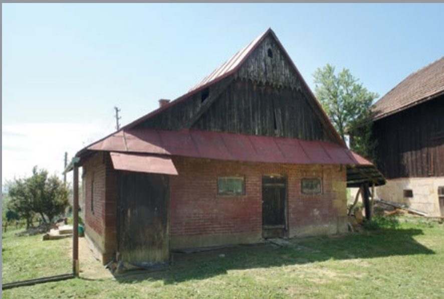
Il. 22. Szczytowa elewacja Pigoniówki w części gospodarczej domu. Widoczne drzwi oraz okna obory oraz nowa podmurówka i kamieniarskie narożniki ścian z piaskowca, fot. T. Łopatkiewicz, maj 2020
