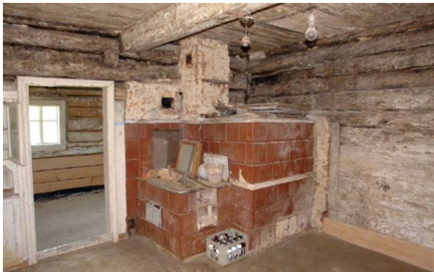
Il. 8. Wnętrze izby z widokiem na współczesne urządzenia ogniowe – kuchnię z piecem chlebowym i kominem, fot. T. Łopatkiewicz, maj 2020
