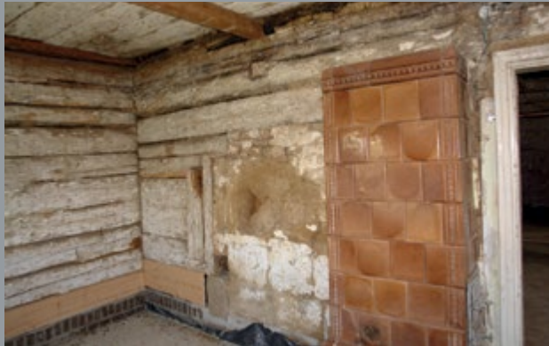
Il. 10. Wewnętrzna ściana warsztatu ze współczesnym piecem kaflowym oraz relikwami wcześniejszych rozwiązań ciesielskich i zdzuńskich, fot. T. Łopatkiewicz, maj 2020
