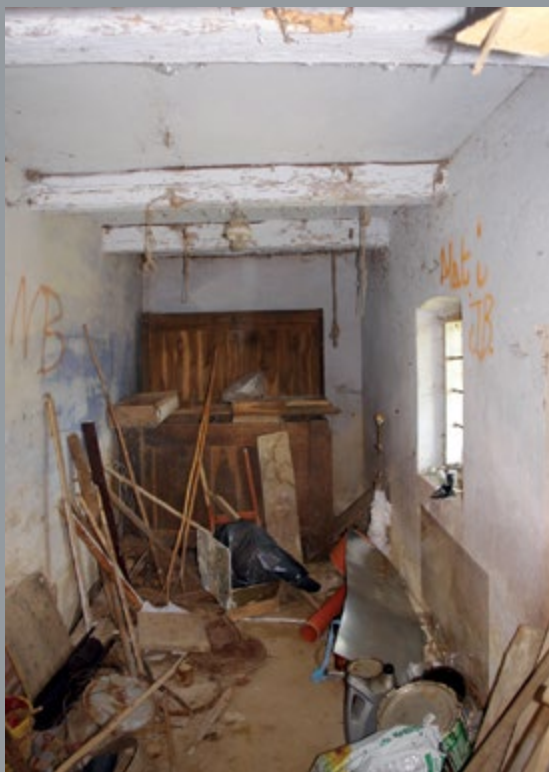
Il. 23. Wnętrze komory, fot. T. Łopatkiewicz, maj 2020
