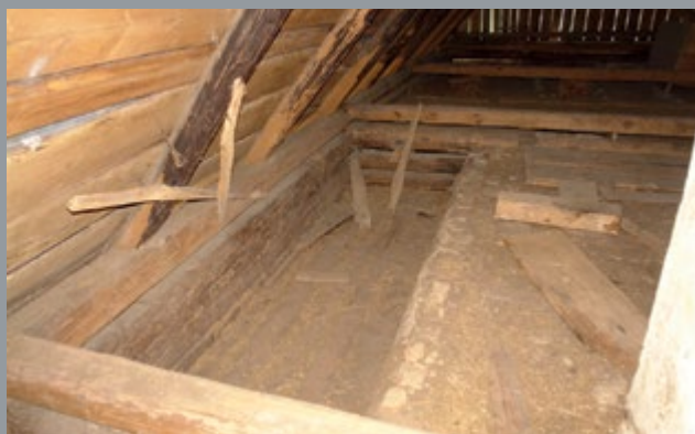
Il. 29. Poddasze Pigoniówki – obniżony strop nad alkierzem (po lewej) i wysoko zawieszony pułap izby (po prawej). Strop nad izbą pokryty jest glinianą polepą – reliktem półkurności chałupy. Ślady długotrwałego oddziaływania dymu widoczne są na wszystkich starych belkach, za wyjątkiem nowej płatwi i wzmacniających je łączników, fot. T. Łopatkiewicz, maj 2020
