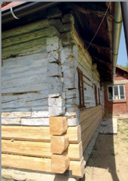
Il. 3. Węglowany na obłap narożnik południowy chałupy. Trzy dolne wieńce belek wymienione w toku niedawnych prac remontowych, fot. T. Łopatkiewicz, maj 2020
