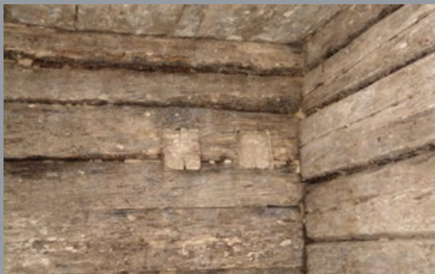
Il. 11. Relikty dawnych poleni zachowane w zrębowych ścianach izby, fot. T. Łopatkiewicz, maj 2020
