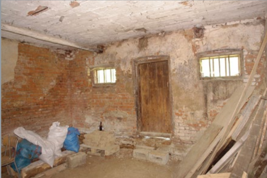
Il. 21. Wnętrze obory z widokiem na ścianę szczytową domu, fot. T. Łopatkiewicz, maj 2020
