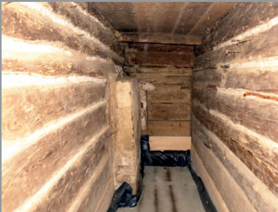
Il. 16. Wnętrze alkierza z nagrzewnicą po lewej stronie i niewielkim świetlikiem w ścianie prawej, fot. T. Łopatkiewicz, maj 2020
