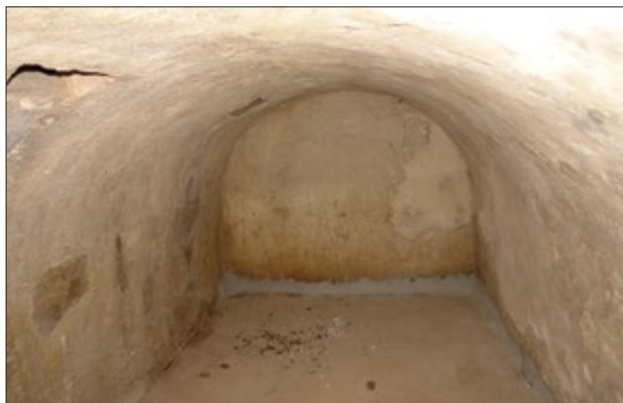
Il. 20. Ściana szczytowa kamiennej piwnicy, po lewej dwa zsypy dostępne z zewnątrz, fot. T. Łopatkiewicz, maj 2020
