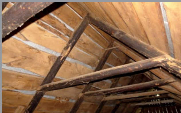
Il. 30. Para starych krokwii pochodzących z pierwotnego dachu czterospadowego i dwa gniazda powyżej jętki, w których osadzona była belka stabilizująca w pionie komin sztagowy, fot. T. Łopatkiewicz, maj 2020
