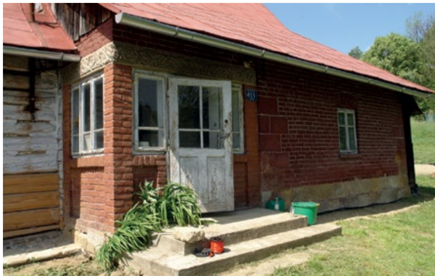
Il. 5. Ganek oraz frontowa ściana wymurowanej z cegły części gospodarczej domu, fot. T. Łopatkiewicz, maj 2020
