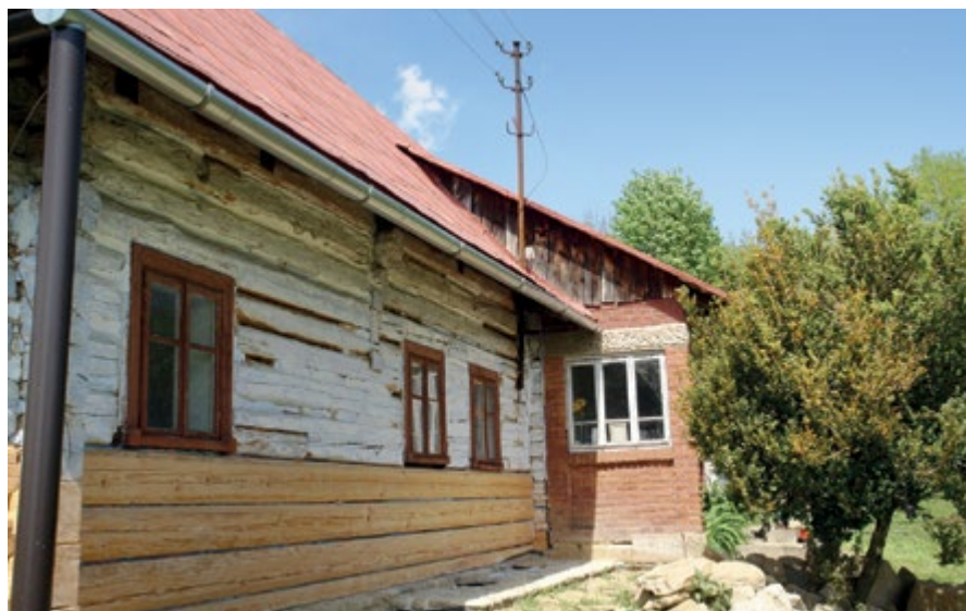
Il. 32. Załamana i podniesiona połać dachowa nad komorą i gankiem, fot. T. Łopkiewicz, maj 2020
