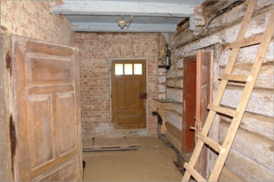
Il. 18. Widok sieni – część od frontu. Po lewej – drzwi do obory, w posadzce – wjazd do piwnicy, na wprost – drzwi na ganek, po prawej – wejście do izby (ze śladami okopcenia zrębu ponad nadprożem) i drabina prowadząca na strych, fot. T. Łopatkiewicz, maj 2020
